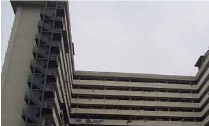
Rajah 1 Rumah pangsa 17 tingkat di Kampung Kerinchi, Kuala Lumpur.
