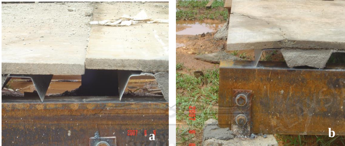
Gambar 6.10 Papan kering yang terjulur memungkinkan (a) ketakrataan lantai dan (b) kepatahan di bucu panel.
