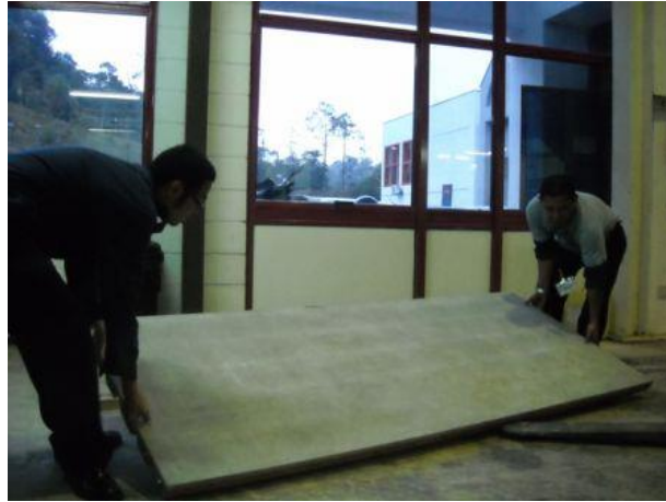
Gambar 6.2 Dua pekerja mengangkat panel lantai PSSDB yang seberat 73 kg.
