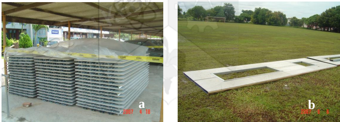
Gambar 6.4 (a) Panel lantai dan (b) dinding pasang siap diletakkan di tapak projek
