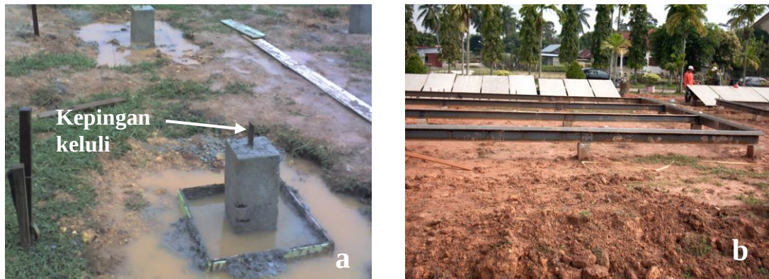
Gambar 6.5 (a) Pembinaan puntung dan (b) pemasangan rasuk kabin
