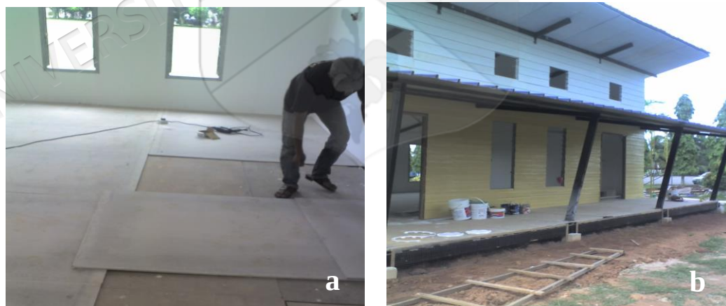
Gambar 6.8 Kerja-kerja pengemasan (a) lantai dan (b) dinding kabin
